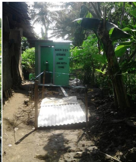
Gambar 4.17:MCK sesudah direnovasi
