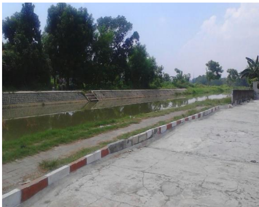
Gambar 3.9 Kondisi Jalan dan Jembatan
