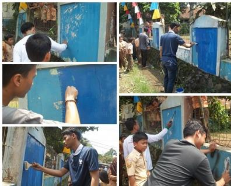
Gambar 4.5: Pengecatan SDN 04 Cibodas
