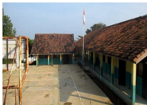
Gambar 3. 8 : Kondisi SMPN 01 Atap
