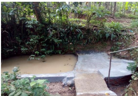
Gambar 4.16: MCK Sesudah Direnovasi
