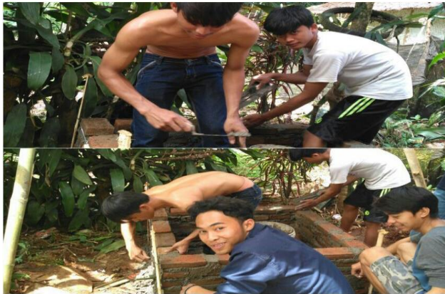
Gambar 4. 9 Pembuatan Tempat Sampah Permanen
