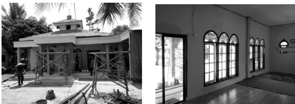
Gambar 4.2: Mushalla Sesudah Renovasi
