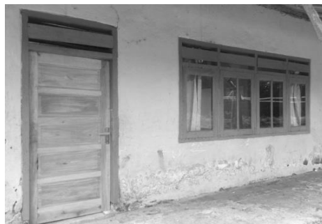
Gambar 4.4: Pintu Sesudah Direnovasi
