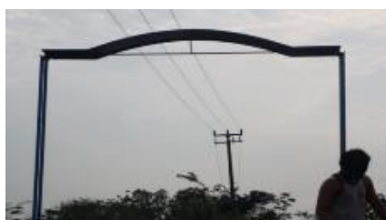
Gambar 4.7 : Gapura Tampak Depan
