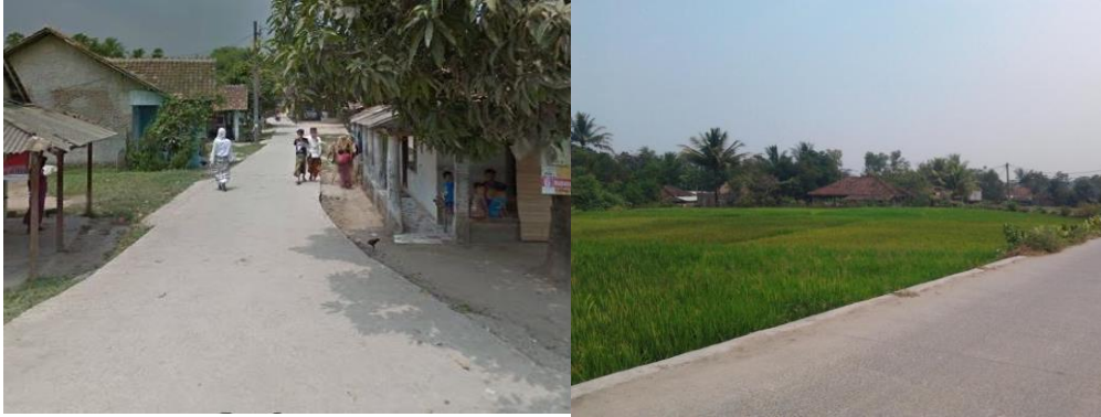
Gambar 3.5: Kondisi Jalan Desa Cireundeu
